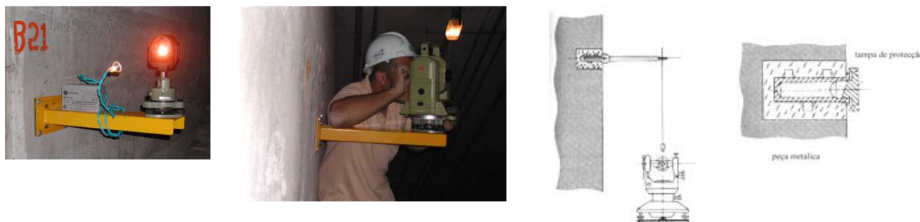
figura 3.13. Estacionamento sob uma marca na parede de uma mina
